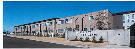
久喜ことぶき苑駐車場
